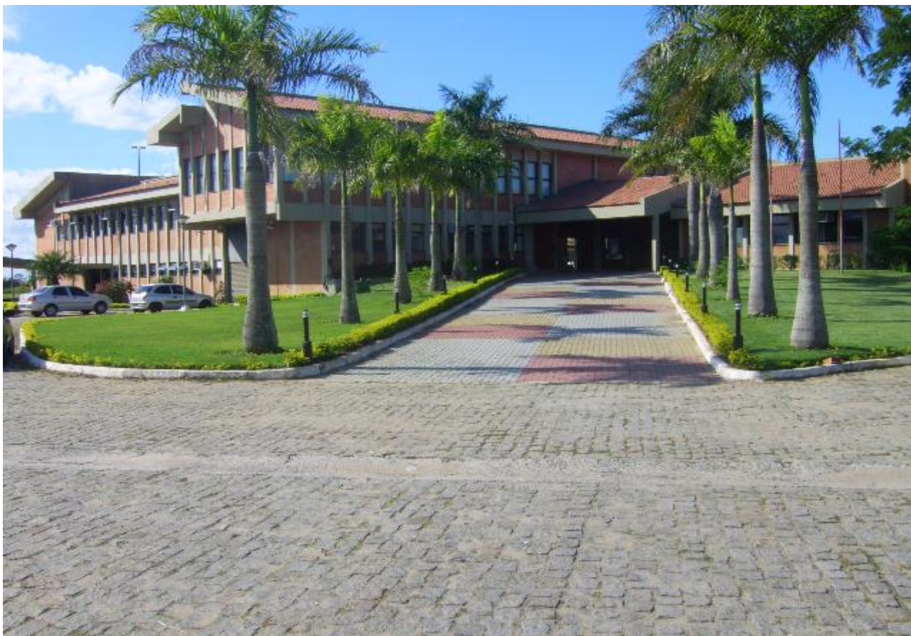
Figura 1: Entrada principal do Campus Serra do Ifes. Fonte: arquivo da diretoria, Jan/2009.
