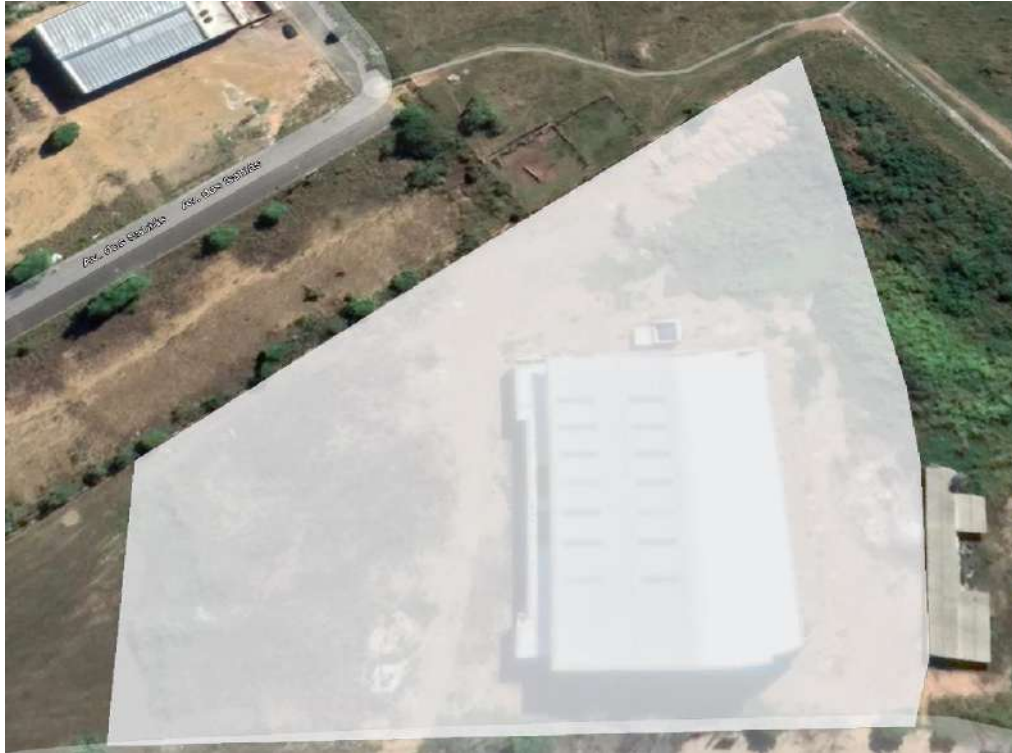
Fig a – Delimitação da área de limpeza.
